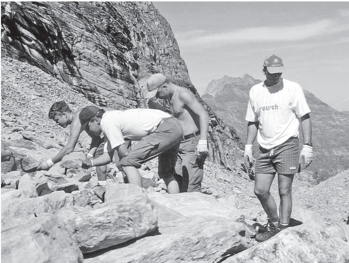
Sanierungsarbeiten am Passo Soreda durch die Lehrlinge der Firma Stutz AG mit Hüttenchef Patrick Maly
