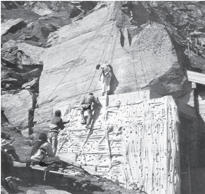
Der Lawinenablenker dient auch als Kletterwand
