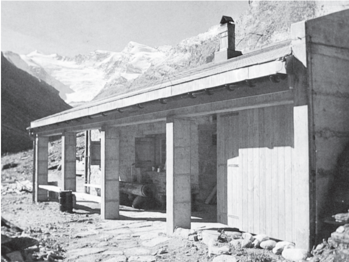
Lawinenschutzwand Nord und Schutzgalerie Ost
