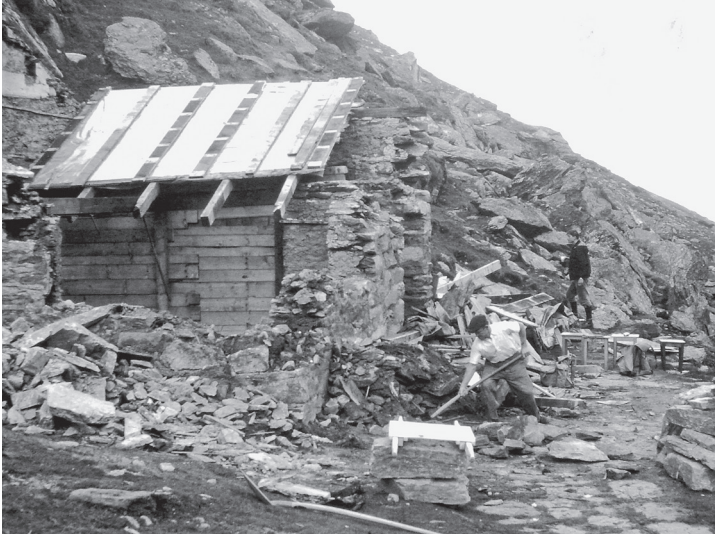
Durch Lawine beschädigte Hütte
