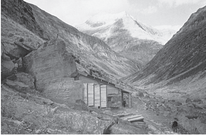
Lawinenablenker und Bohlenwand Süd
