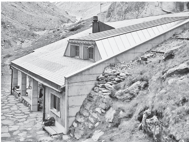
Die umgebaute Hütte mit Dachgaube (Blick nach Süden)
