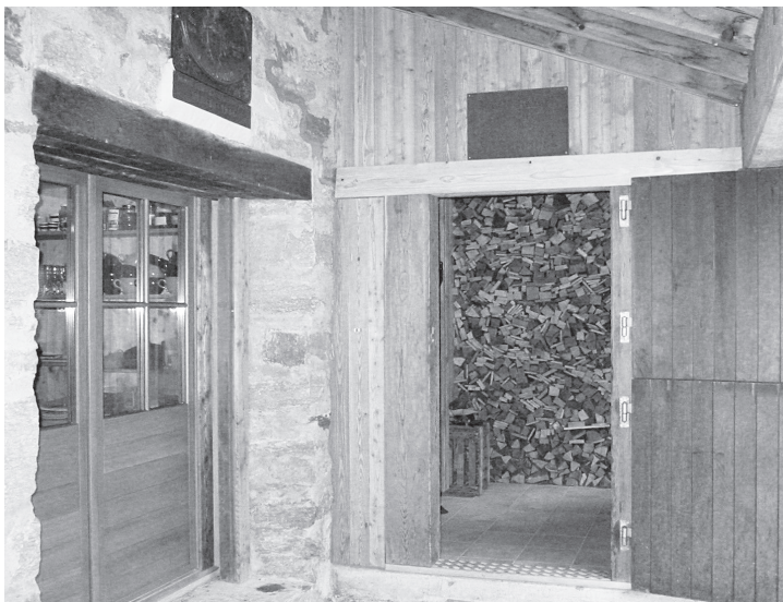
Der neue Hütteneingang führt jetzt durch den Holzraum
