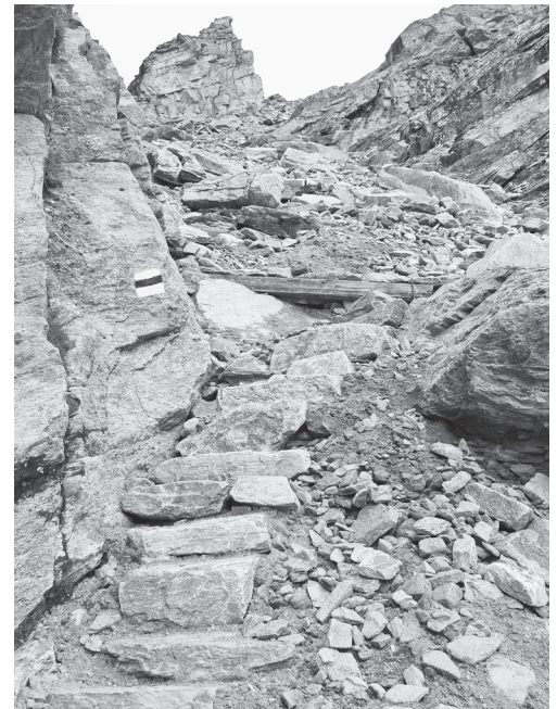
Ausgebauter Aufstieg zum Soredapass
