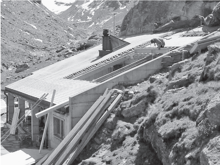
Aussparung für die neue Dachgaube
